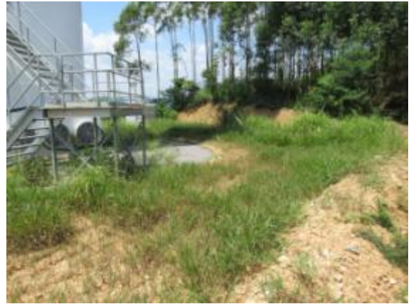
平台挡水土坝
