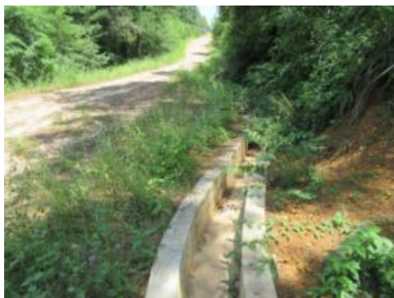
道路空心砖砌排水沟、管涵
