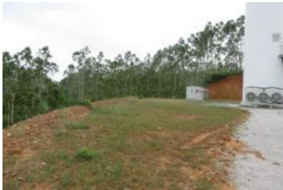
平台挡水土坝
