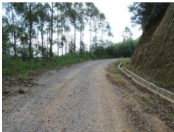
道路空心砖砌排水沟、路面两侧绿化
