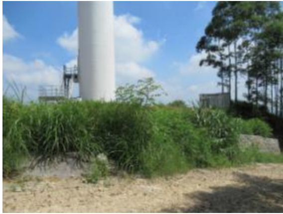
风机平台边坡绿化
