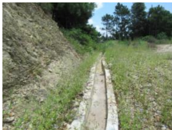
道路空心砖砌排水沟
