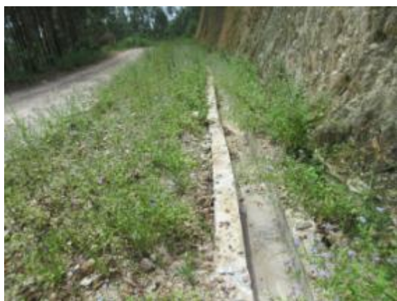
道路空心砖砌排水沟
