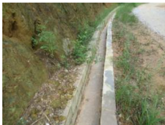
道路空心砖砌排水沟
