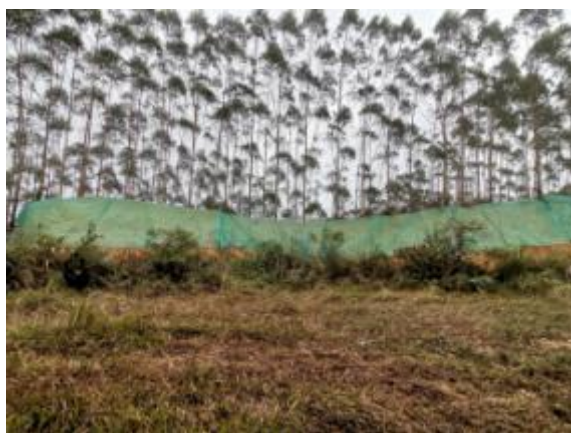
风机平台边坡喷播植草+无纺布苫盖
