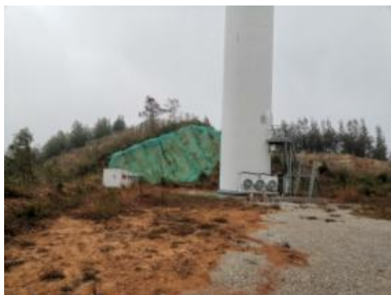
风机平台边坡喷播植草+无纺布苫盖
