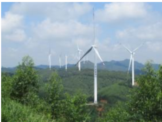
风电项目全貌
