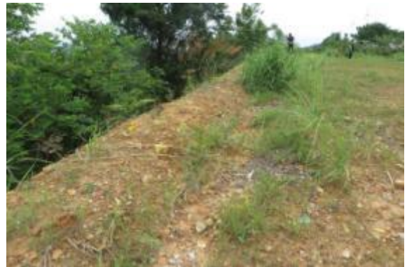
平台挡水土坝
