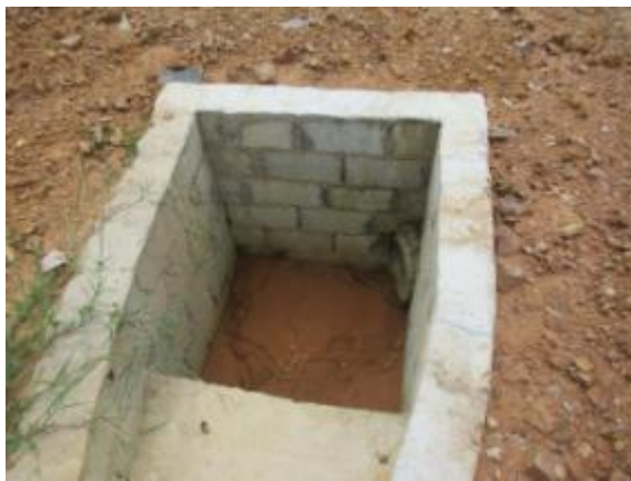
道路空心砖沉沙池、管涵
