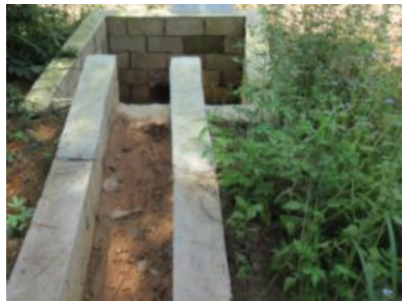
道路空心砖沉沙池、管涵
