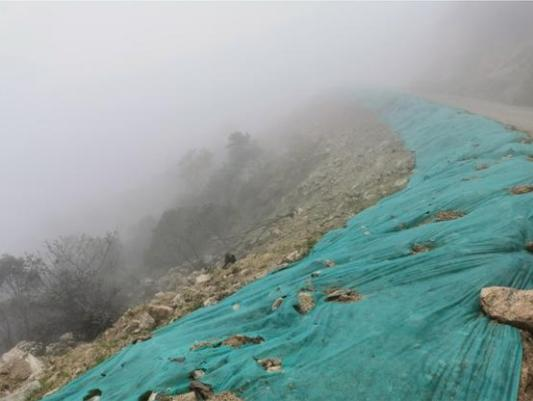
道路沿线边坡挂网混喷植生绿化
