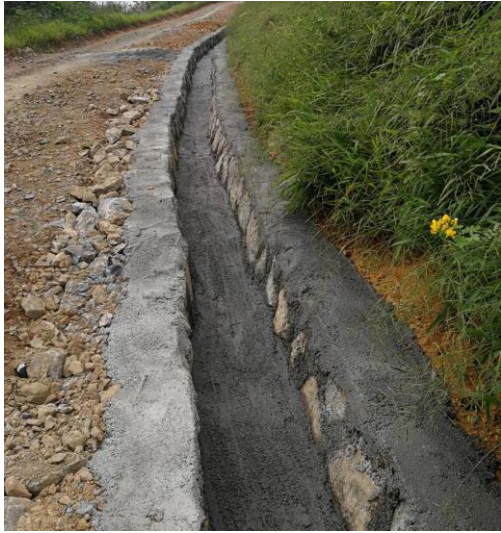
F22 风机检修支路道路排水
