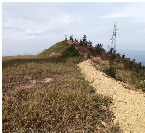
F21 风机平台土坎拦挡
