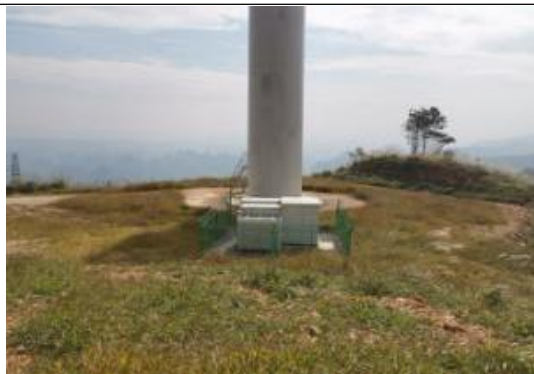
F17 风机平台
