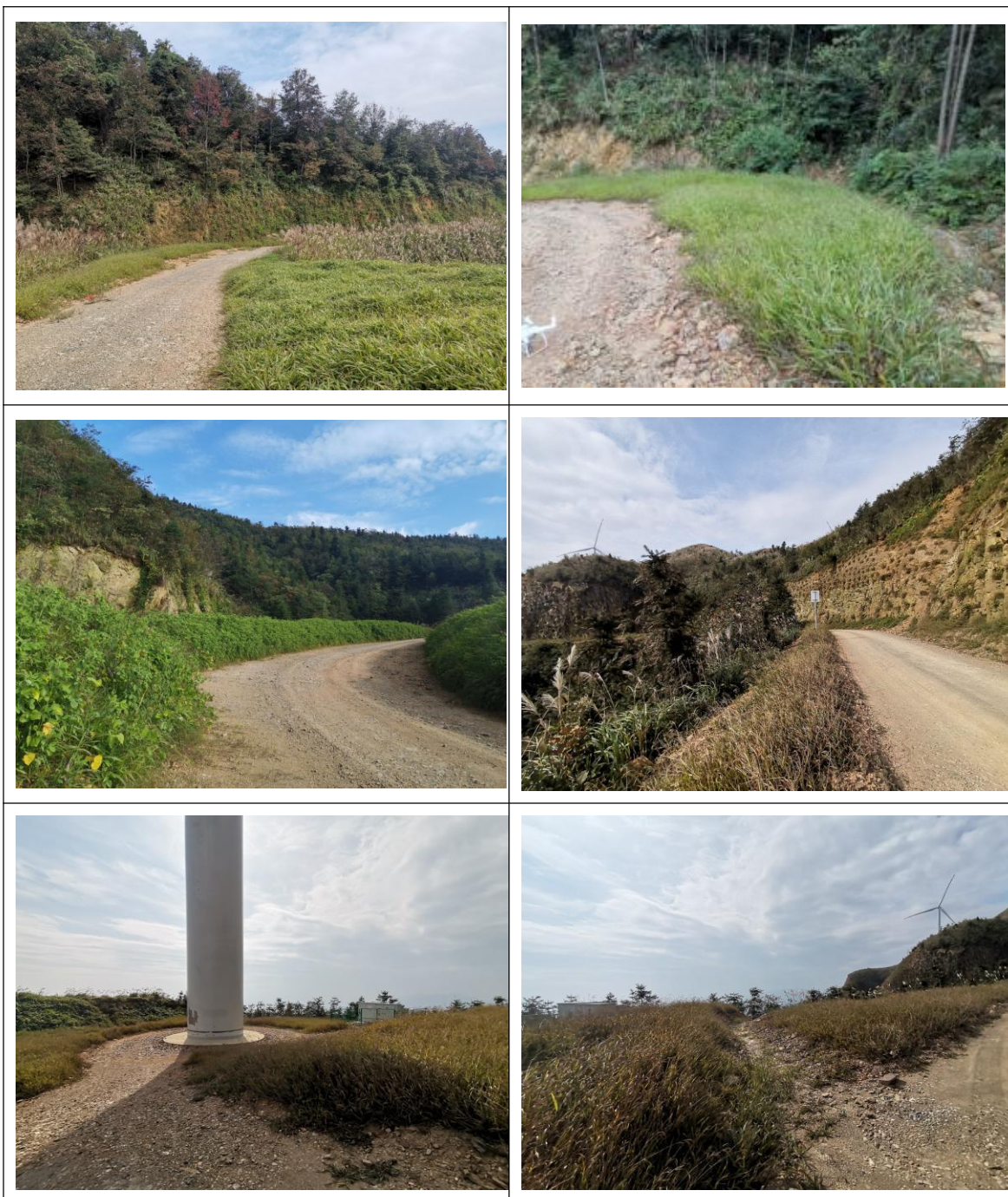
图 8-6 临时堆土恢复情况
