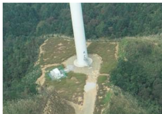
F16 风机平台
