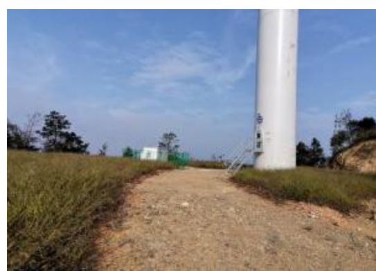
F8 风机平台
