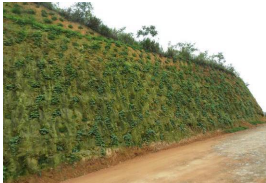
检修道路上边坡绿化
