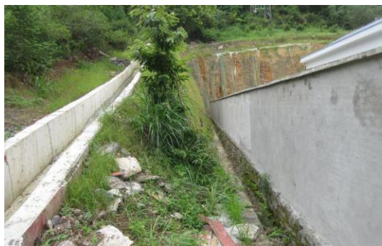
升压站外排水
