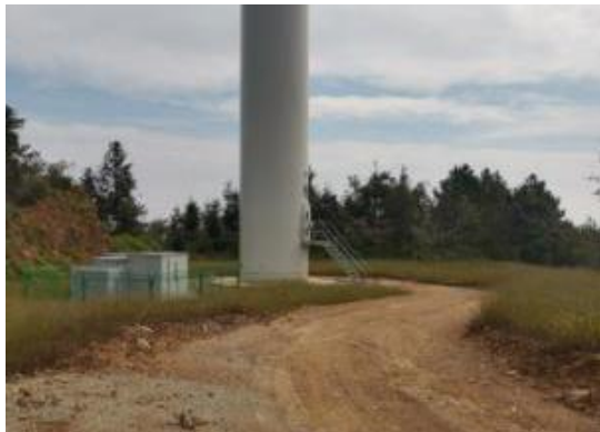
F15 风机平台
