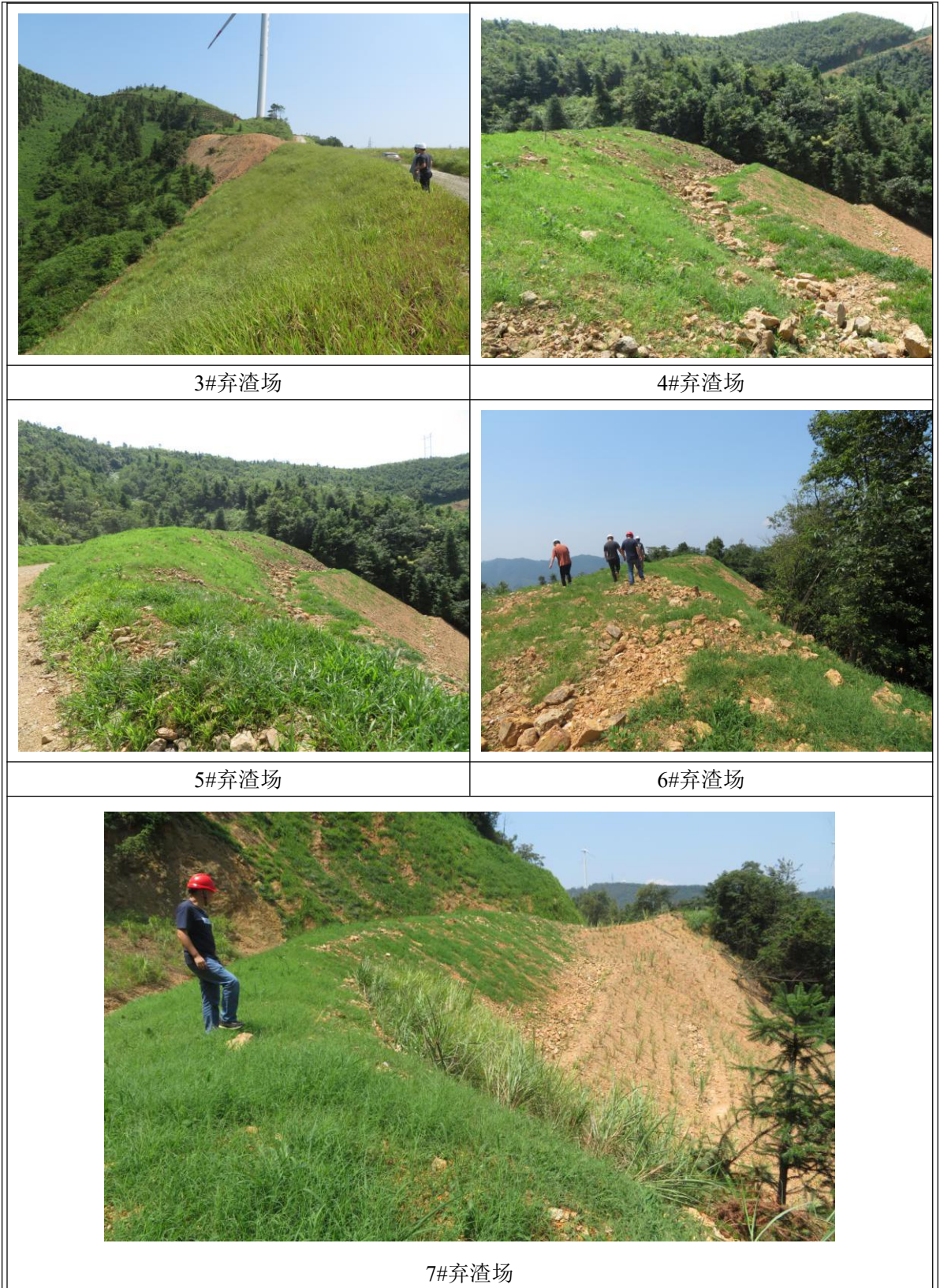
图 8-5 弃渣场恢复情况图片
