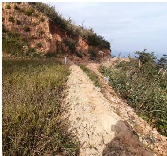
F21 风机平台土坎拦挡
