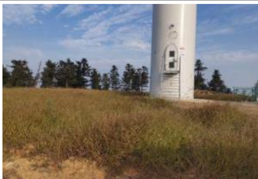
F11 风机平台
