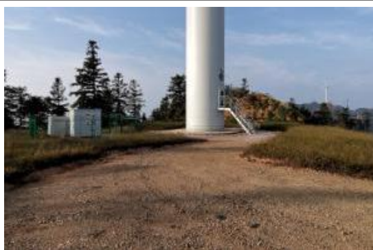
F12 风机平台
