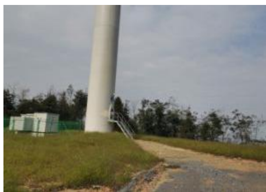
F4 风机平台
