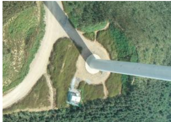
F20 风机平台
