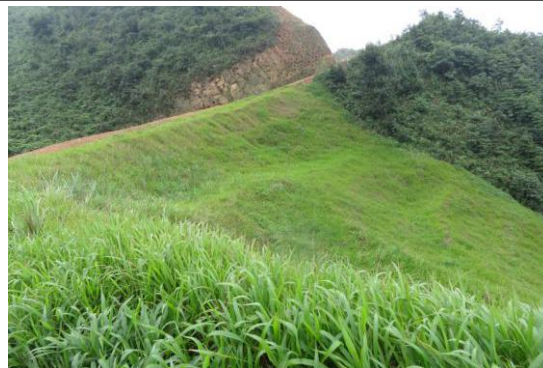
检修道路下边坡绿化恢复
