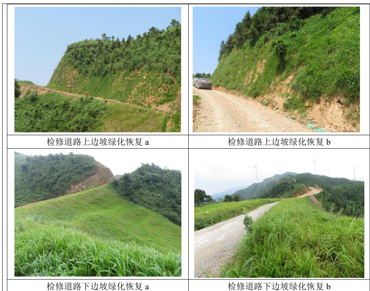
图 8-2 道路绿化恢复图片片
