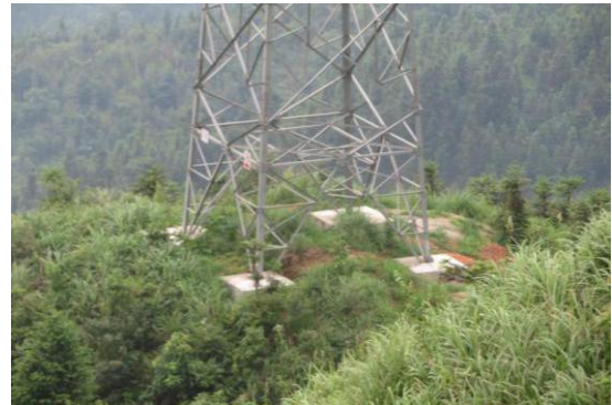
集电线路塔基恢复
