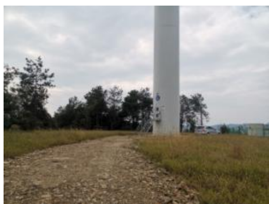
F1 风机平台
