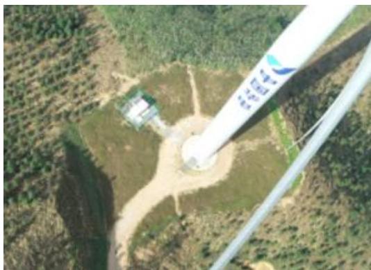
F19 风机平台
