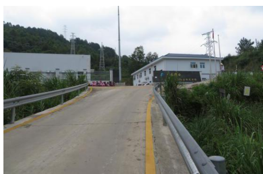
升压站进站道路
