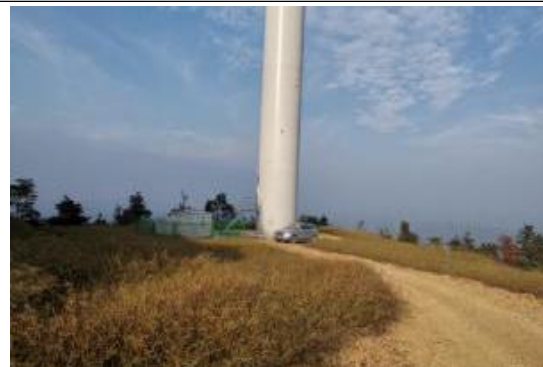
F10 风机平台
