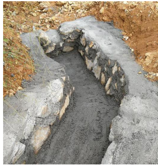
F22 风机检修支路道路排水消力坎型沉沙池
