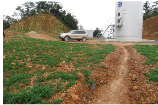
风机平台排水沟
