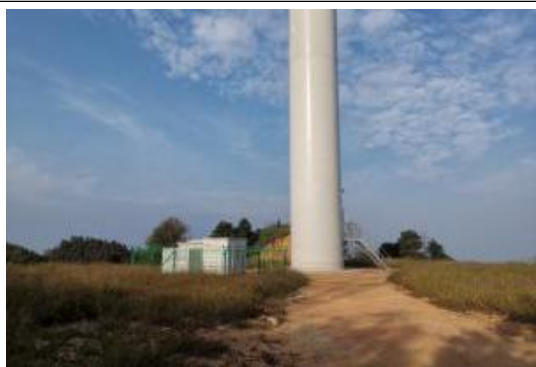
F9 风机平台
