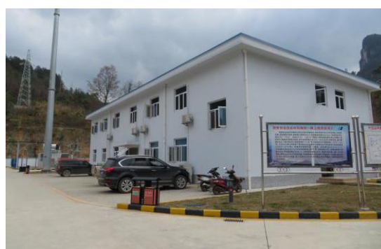
升压站综合楼
