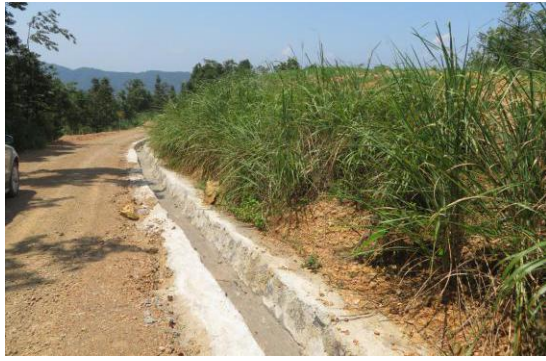
检修道路排水沟
