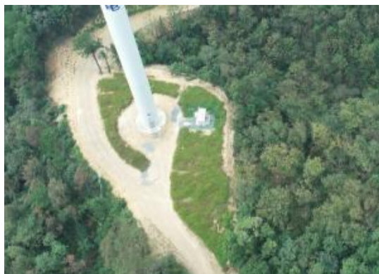
F3 风机平台
