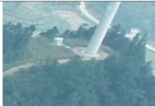
F18 风机平台
