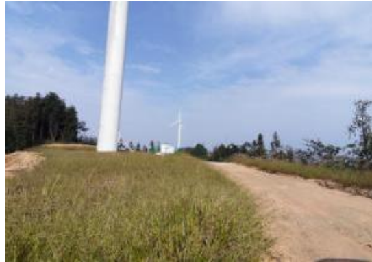
F6 风机平台
