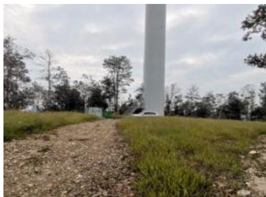
F2 风机平台
