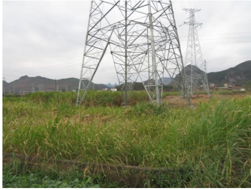
塔基植被恢复情况
