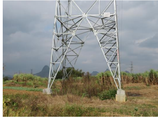
塔基植被恢复情况
