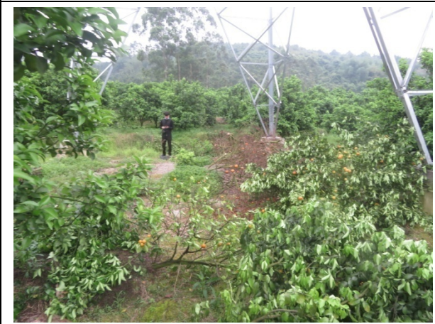
杆塔施工区植被恢复（110kV 起新线 66 号）
