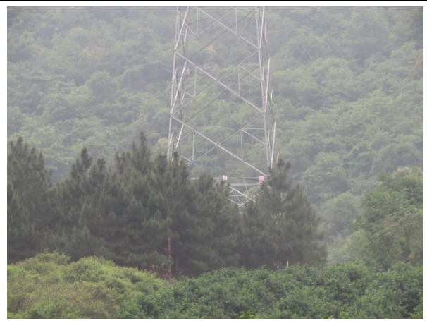
杆塔施工区植被恢复（110kV 起新线 50 号）
