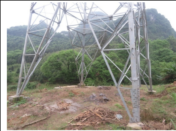
杆塔施工区植被恢复（110kV 起新线 41 号）
