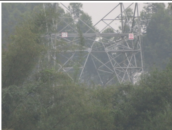
杆塔施工区植被恢复（110kV 起新线 77 号）
