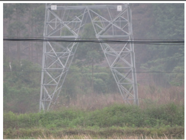
杆塔施工区植被恢复（110kV 起新线 67 号）
