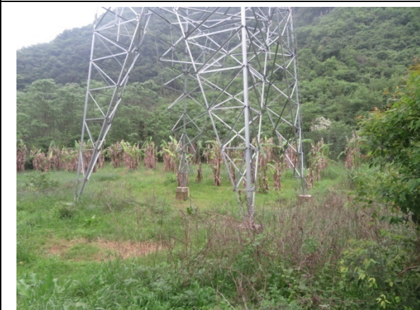
杆塔施工区植被恢复（110kV 起新线 47 号）
