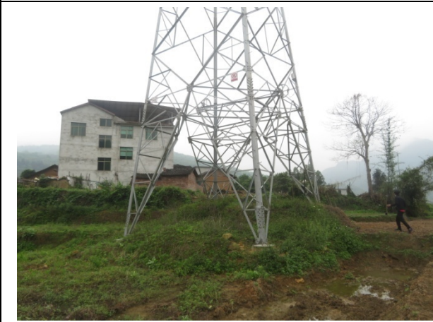
杆塔施工区植被恢复（110kV 起新线 43 号）
