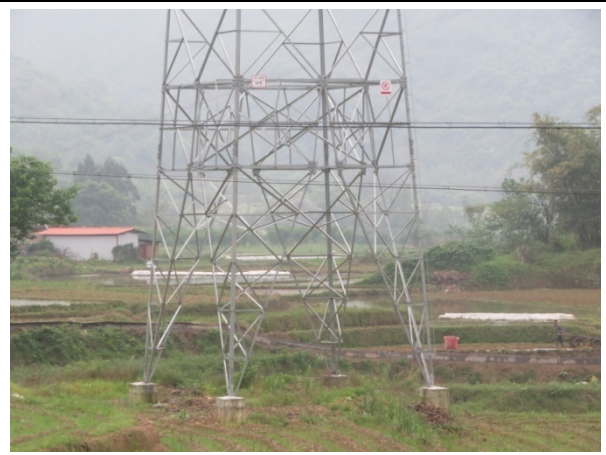
杆塔施工区植被恢复（110kV 起新线 42 号）
