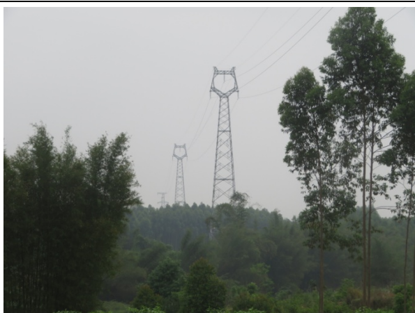
杆塔施工区植被恢复（起新线 50-60 塔段）
