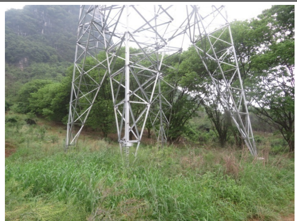
杆塔施工区植被恢复（110kV 起新线 48 号）
