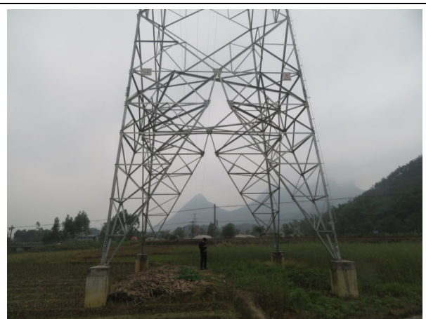
杆塔施工区植被恢复（110kV 起新线 75 号）
