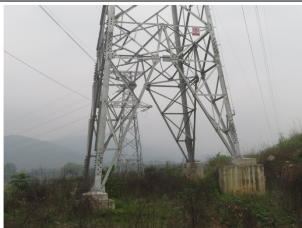
杆塔施工区植被恢复（110kV 起新线 80 号）
