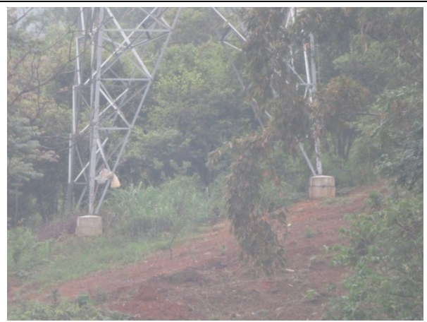
杆塔施工区植被恢复（110kV 起新线 44 号）
