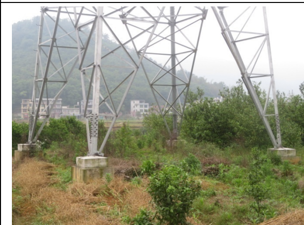
杆塔施工区植被恢复（110kV 起新线 74 号）
