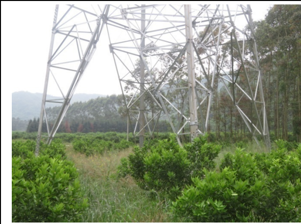
杆塔施工区植被恢复（110kV 起新线 49 号）
