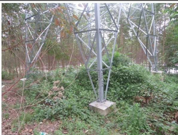
杆塔施工区植被恢复（110kV 起新线 79 号）
