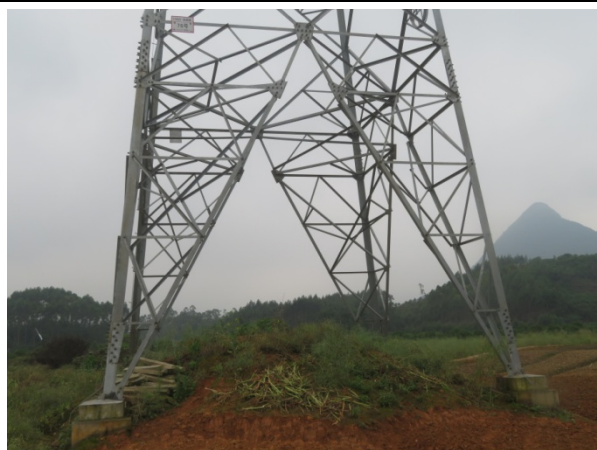
杆塔施工区植被恢复（110kV 起新线 78 号）
