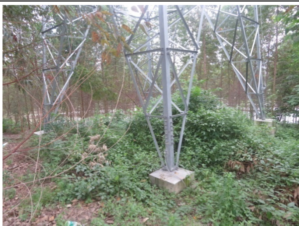
杆塔施工区植被恢复（110kV 起新线 79 号）
