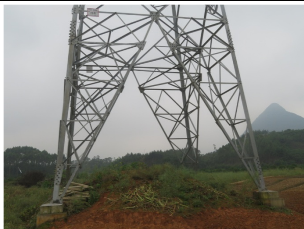
杆塔施工区植被恢复（110kV 起新线 78 号）
