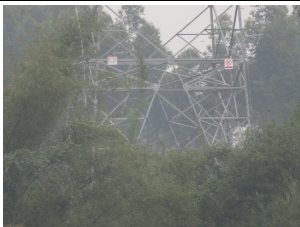
杆塔施工区植被恢复（110kV 起新线 77 号）
