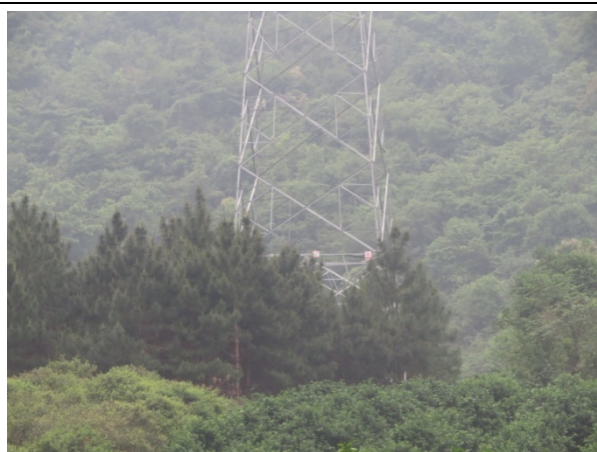
杆塔施工区植被恢复（110kV 起新线 50 号）
