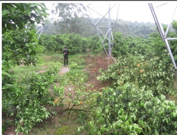
杆塔施工区植被恢复（110kV 起新线 66 号）
