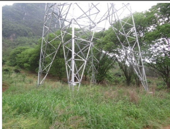
杆塔施工区植被恢复（110kV 起新线 48 号）
