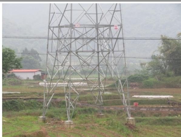
杆塔施工区植被恢复（110kV 起新线 42 号）
