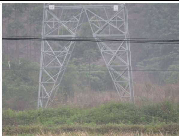
杆塔施工区植被恢复（110kV 起新线 67 号）
