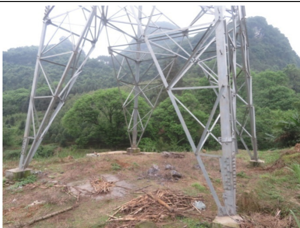
杆塔施工区植被恢复（110kV 起新线 41 号）
