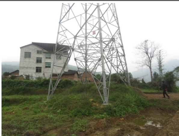
杆塔施工区植被恢复（110kV 起新线 43 号）
