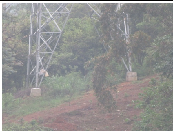
杆塔施工区植被恢复（110kV 起新线 44 号）
