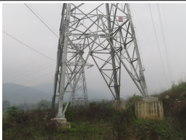
杆塔施工区植被恢复（110kV 起新线 80 号）
