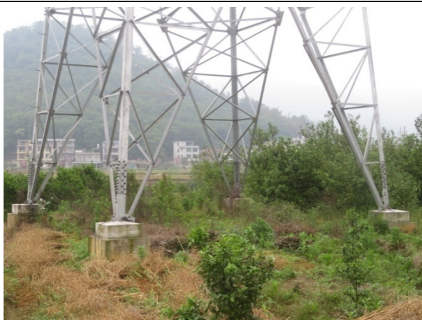
杆塔施工区植被恢复（110kV 起新线 74 号）
