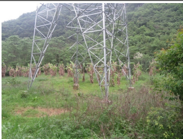
杆塔施工区植被恢复（110kV 起新线 47 号）
