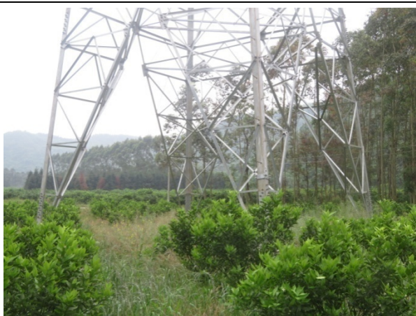
杆塔施工区植被恢复（110kV 起新线 49 号）
