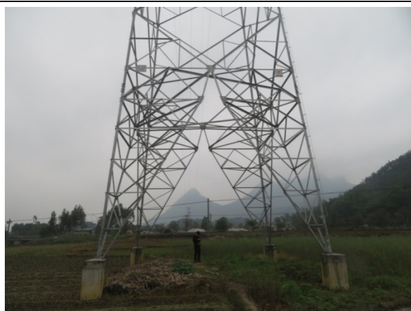
杆塔施工区植被恢复（110kV 起新线 75 号）
