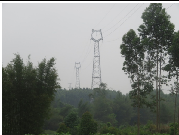
杆塔施工区植被恢复（起新线 50-60 塔段）
