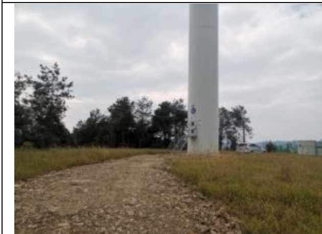
1#风机平台混播草籽绿化
