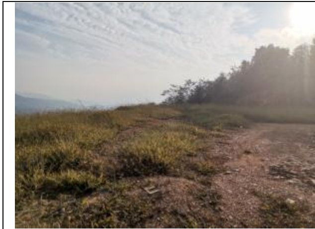
13#风机平台混播草籽绿化
