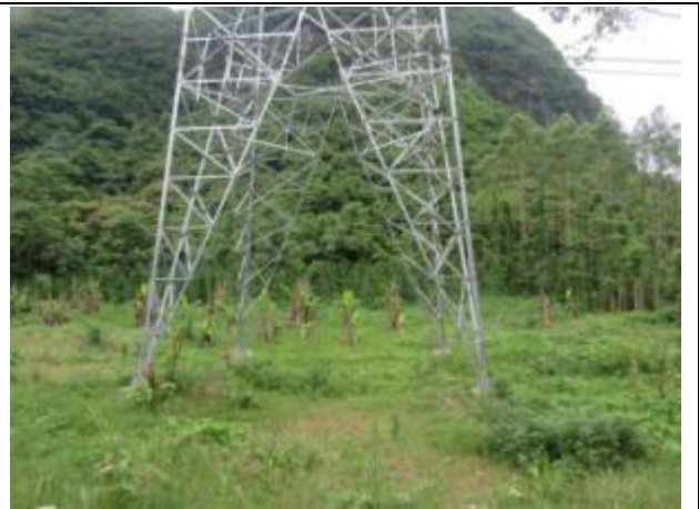
集电线路区撒播草籽绿化
