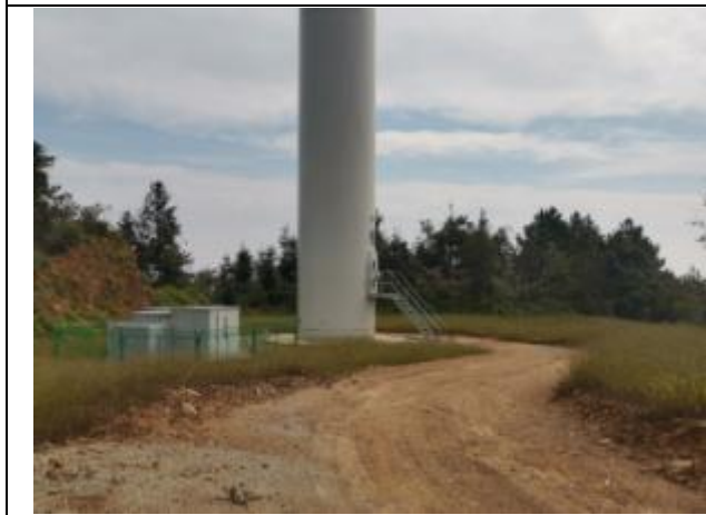
15#风机平台混播草籽绿化
