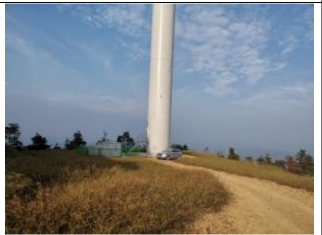
10#风机平台混播草籽绿化
