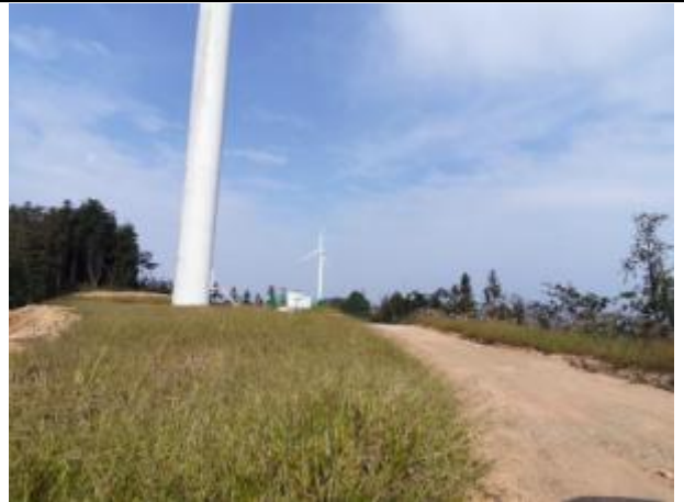
6#风机平台混播草籽绿化
