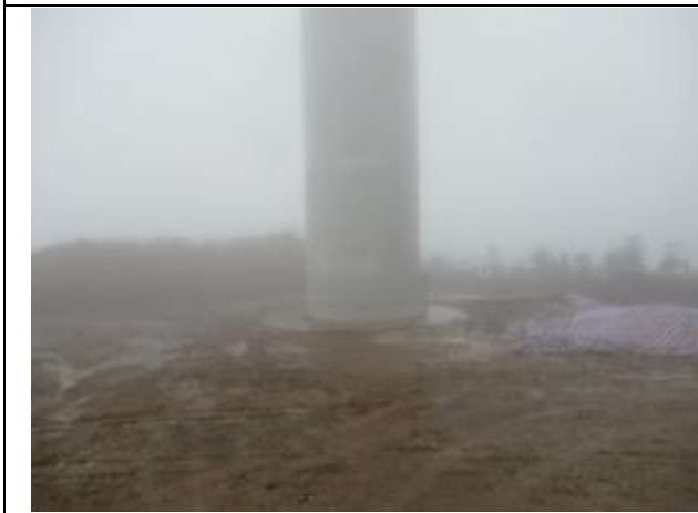
临时堆土彩条布苫盖
