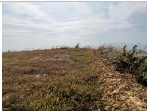
21#风机平台混播草籽绿化
