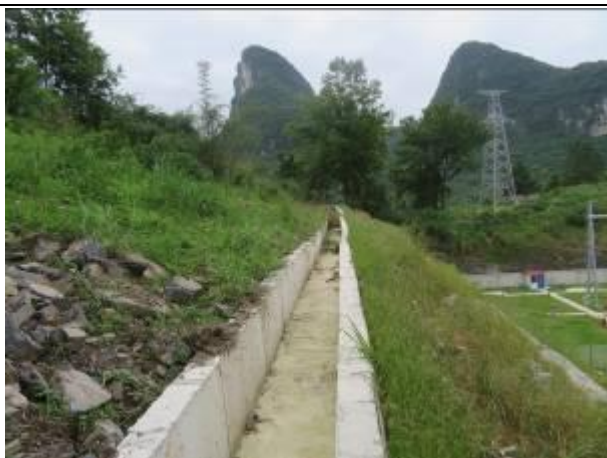
升压站上边坡截水沟
