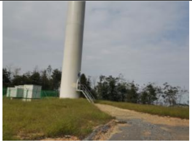
4#风机平台混播草籽绿化
