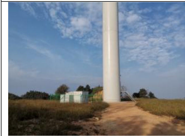
9#风机平台混播草籽绿化
