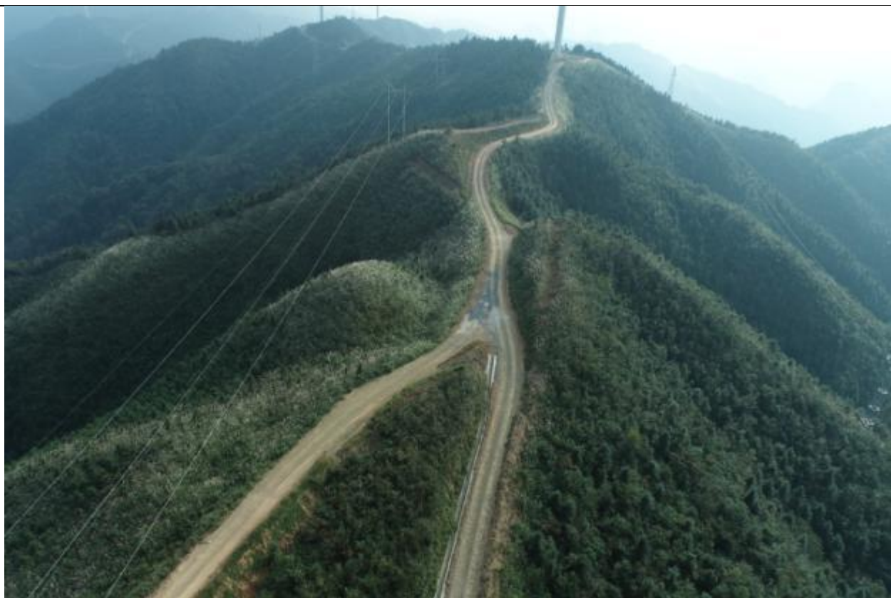
道路边坡绿化效果及浆砌石排水沟
