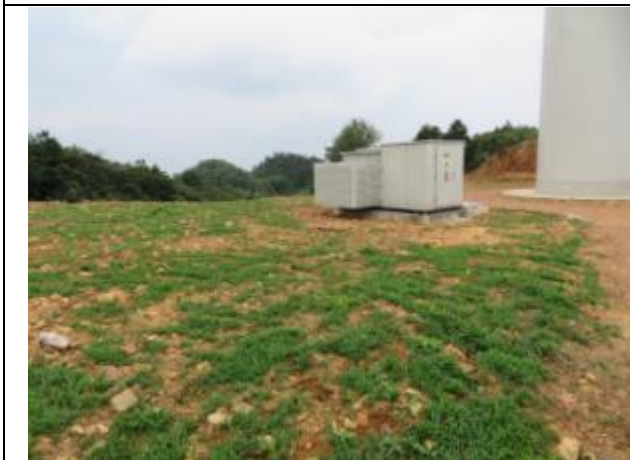
风机平台混播草籽绿化
