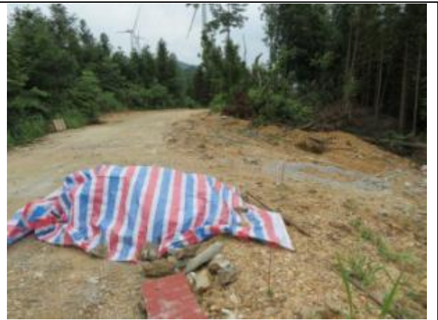
临时堆土彩条布苫盖
