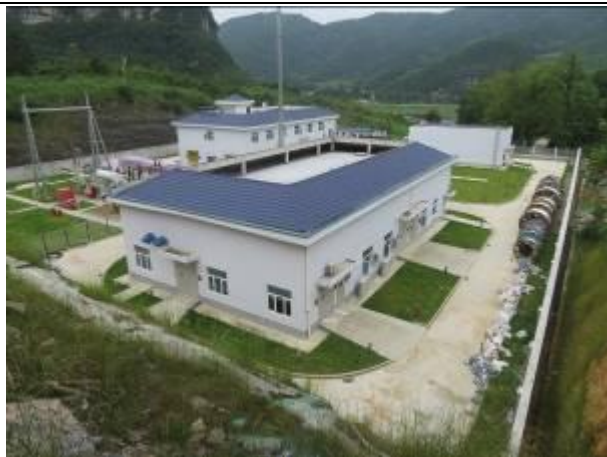
升压站站区绿化及站外排水沟
