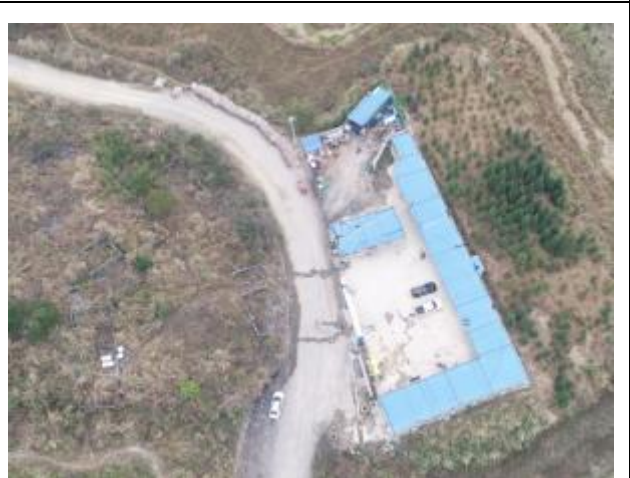
2#施工生产生活区
