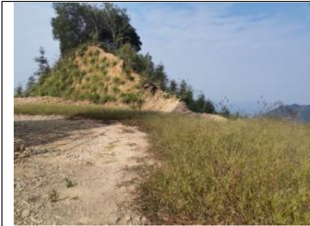
7#风机平台混播草籽绿化
