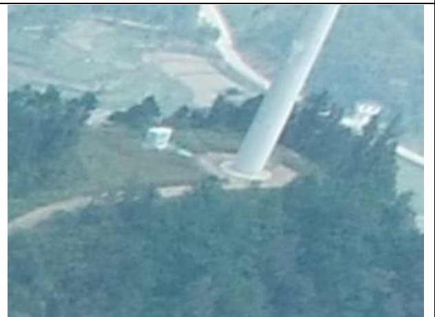
18#风机平台混播草籽绿化
