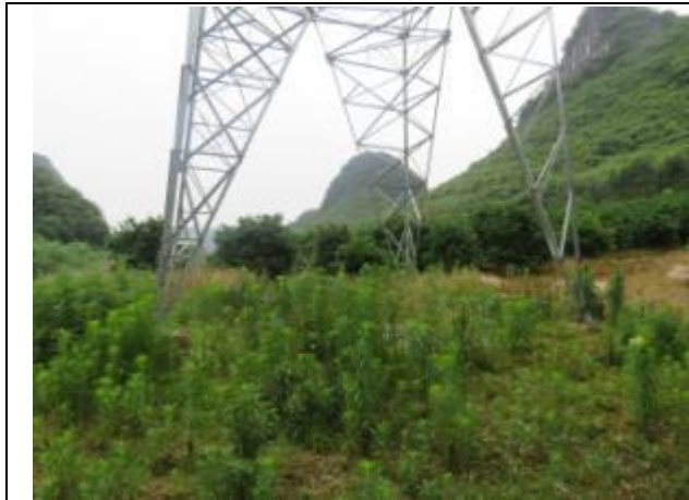
集电线路区撒播草籽绿化
