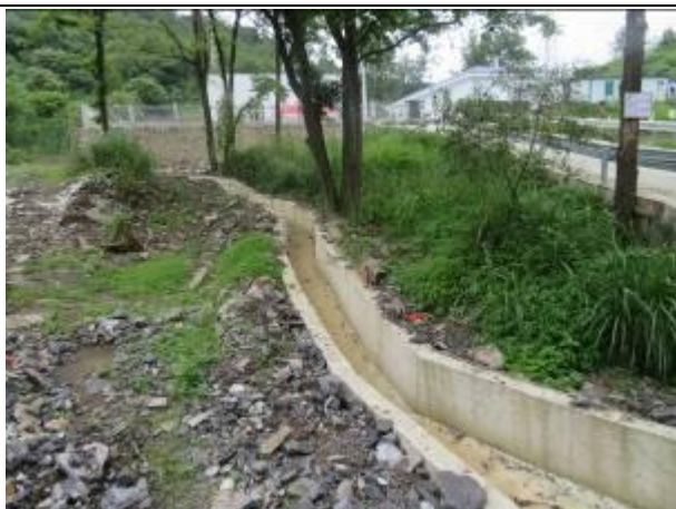
升压站排水沟
