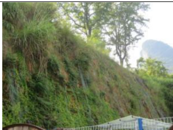
短锚杆+高性能加筋生态基材喷播绿化
