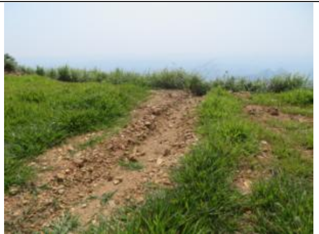
风机平台土质排水沟
