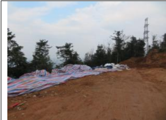
临时堆土彩条布苫盖
