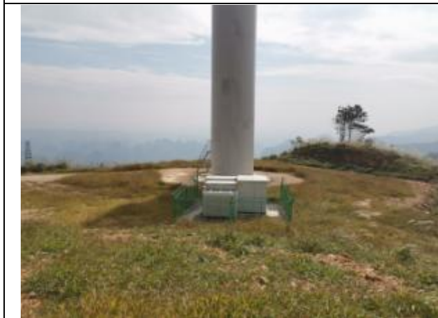
17#风机平台混播草籽绿化
