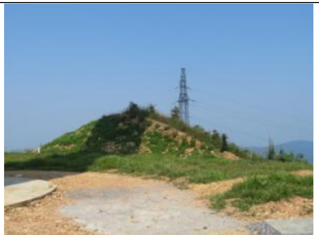
风机挖方边坡打孔穴播绿化
