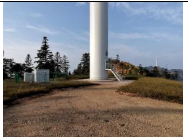
12#风机平台混播草籽绿化
