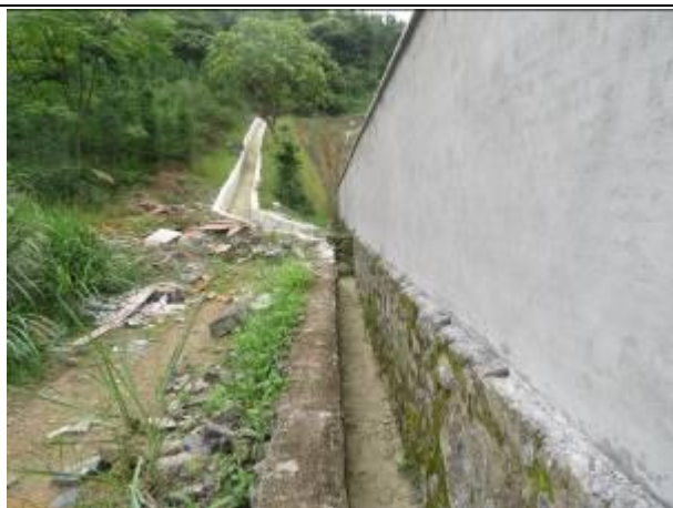
升压站（截）排水沟
