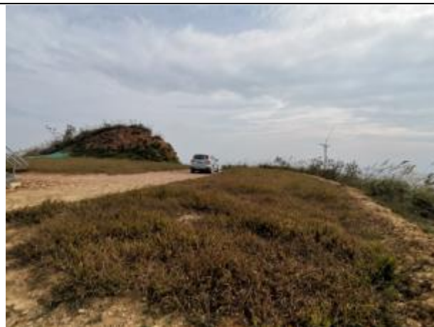
22#风机平台混播草籽绿化
