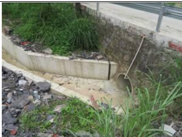
升压站排水沟接进站道路涵管
