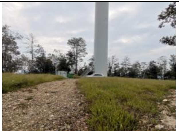
2#风机平台混播草籽绿化
