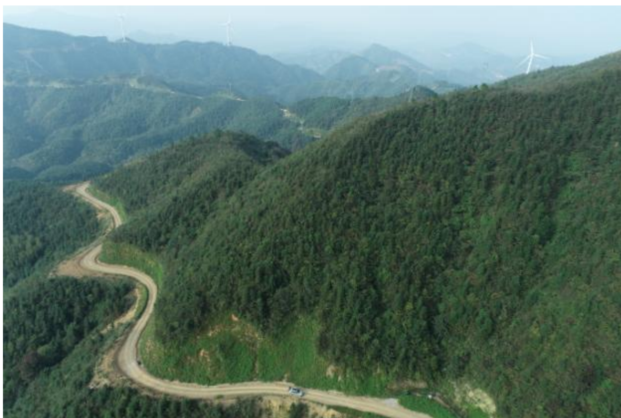
道路边坡绿化效果及浆砌石排水沟
