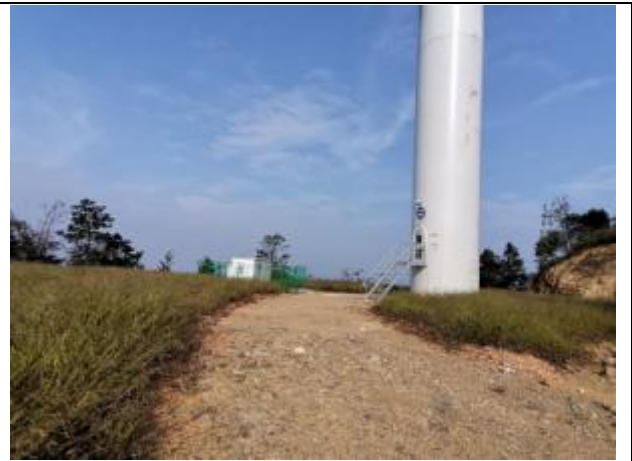
8#风机平台混播草籽绿化
