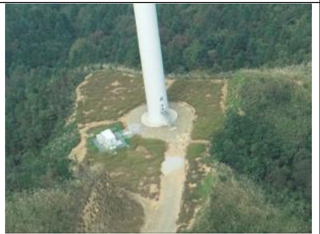
16#风机平台混播草籽绿化
