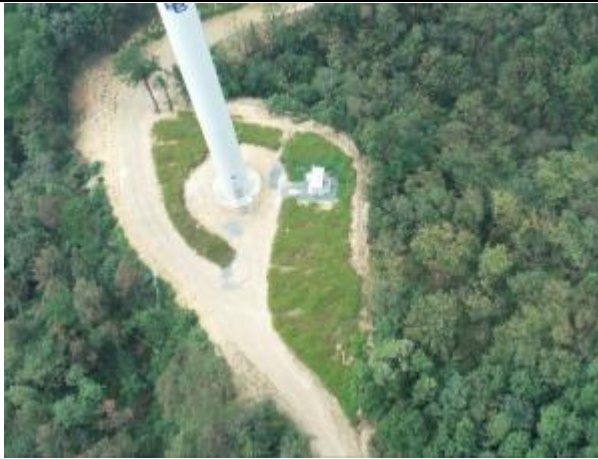
3#风机平台混播草籽绿化
