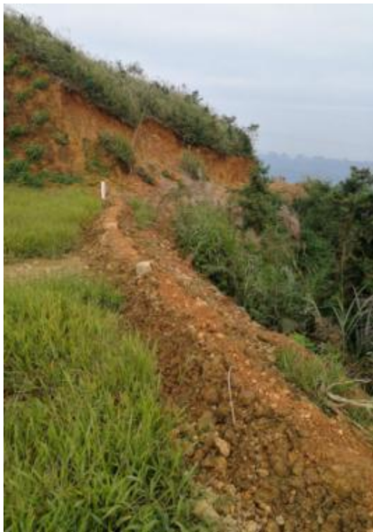
22#风机平台边缘设土坎拦挡
