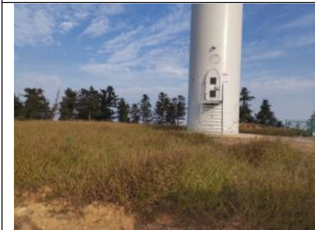
11#风机平台混播草籽绿化
