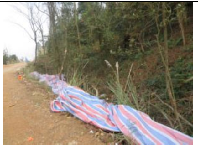
临时堆土彩条布苫盖
