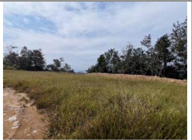
14#风机平台混播草籽绿化
