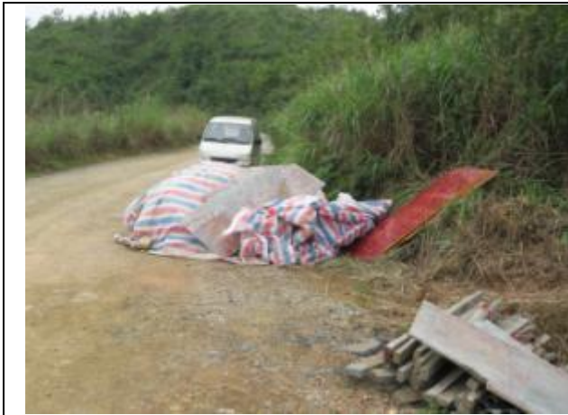
临时堆土彩条布苫盖
