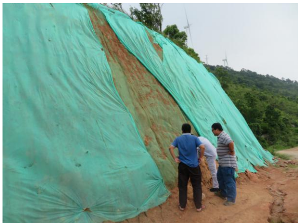
道路区上边坡挂网喷播现场核查
