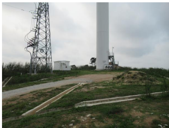
1#风机平台内排水
