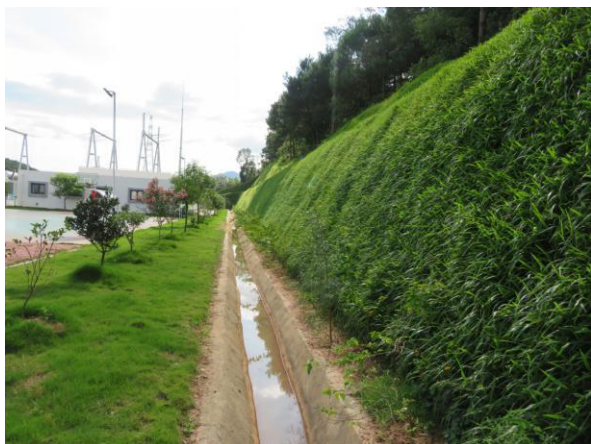
站内截排水设施
