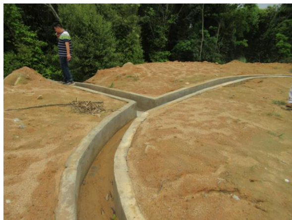
风机平台排水
