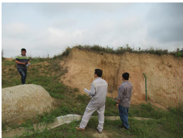
场内道路边坡核查
