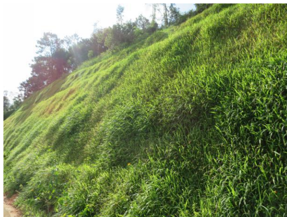
站内边坡绿化（挂网喷播）
