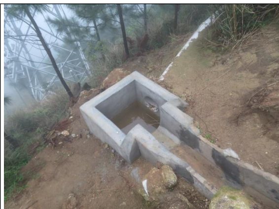
15#风机平台沉砂设施
