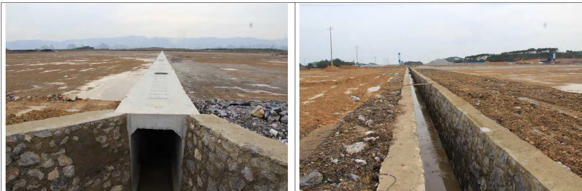
施工过程中水土保持措施实施照片
