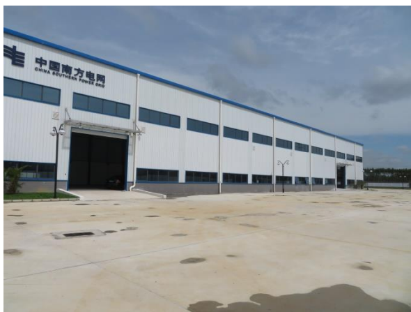
主体工程区绿化及排水 1
