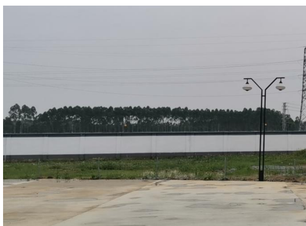
施工生产生活区绿化 1
