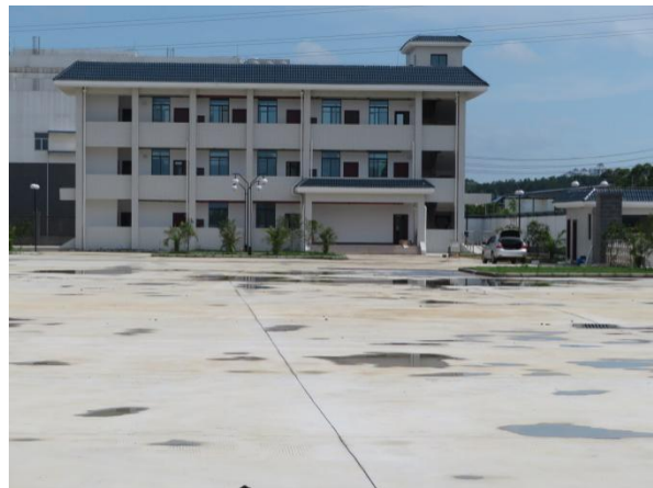
主体工程区绿化及排水 4
