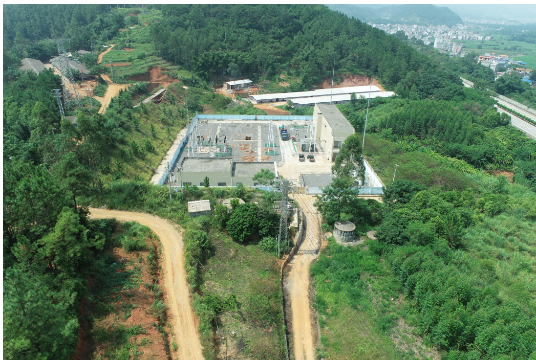
附图 1 110kV 新圩变电站及进场道路
