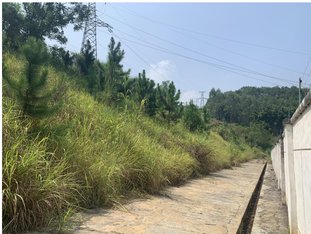
附图 4 变电站周边截排水沟
