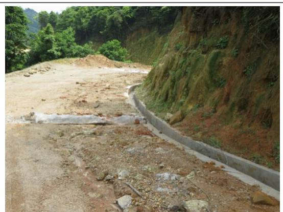
道路内侧混凝土排水沟
