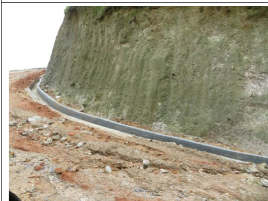
道路内侧混凝土排水沟
