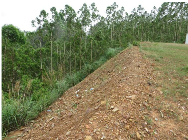
风力发电场区吊装平台边坡绿化 1
