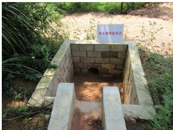
3#~4#风机道路排水沟末端监测点
