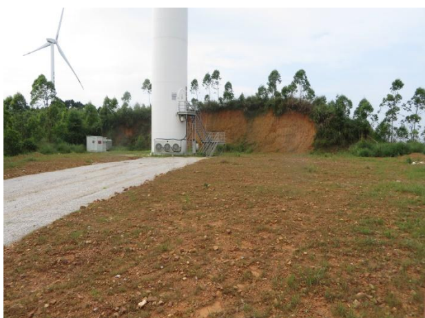
风力发电场区吊装平台绿化 2
