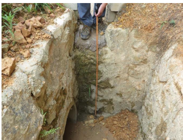
道路排水管涵 1
