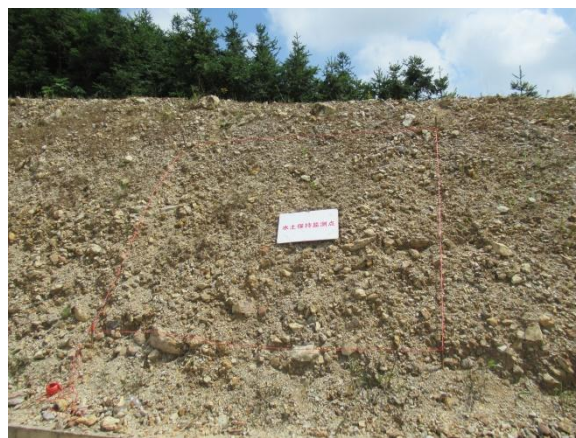
8#风机支路道路填方边坡监测点
