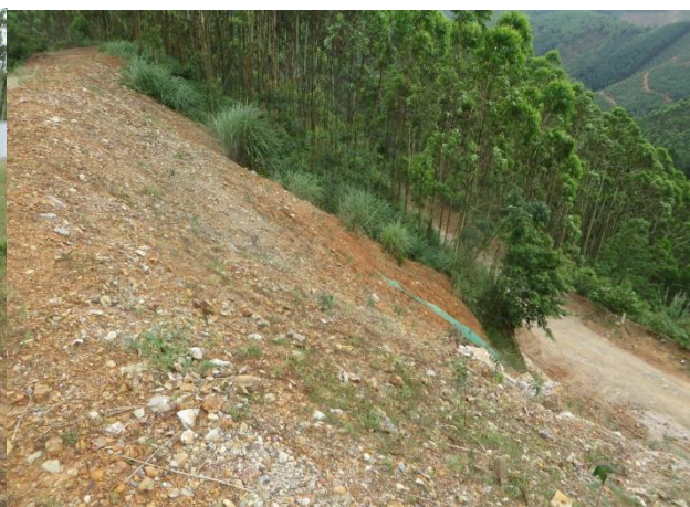
风力发电场区吊装平台边坡绿化 2
