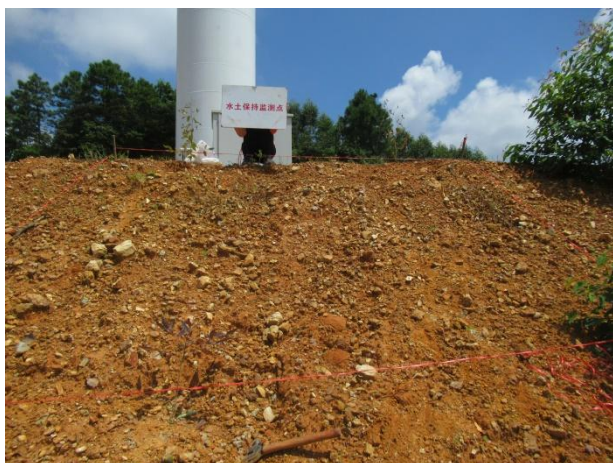
15#风机支路道路填方边坡监测点
