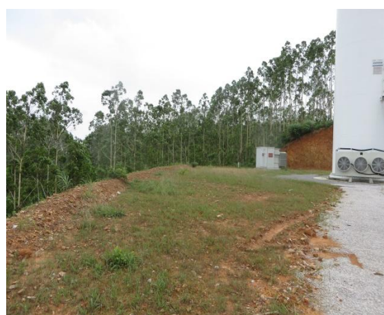
风力发电场区吊装平台绿化 1
