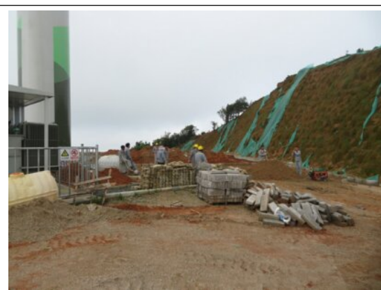
风机平台覆绿施工现场
