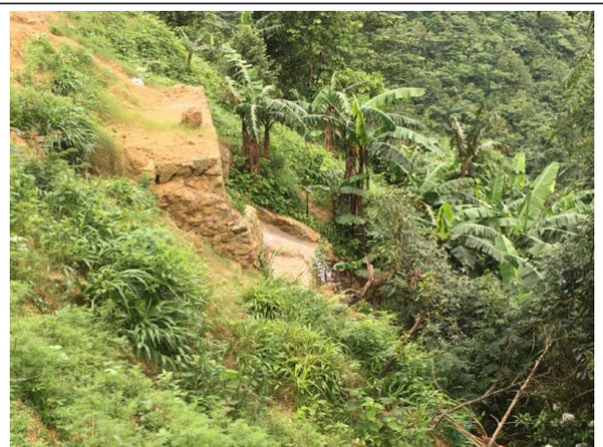
道路过水涵洞出口
