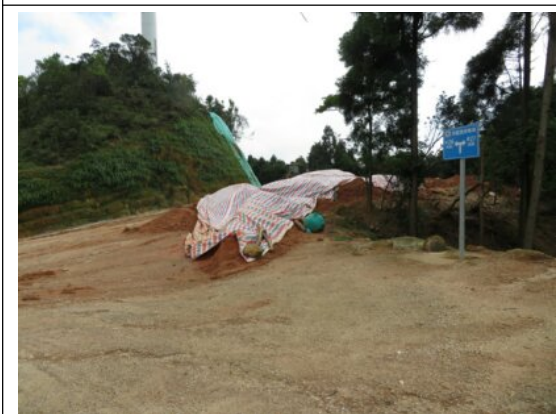
临时堆土苫盖防护
