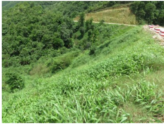
道路下边坡覆绿
