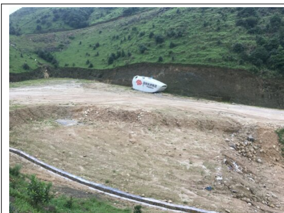
1#弃渣场覆绿前
