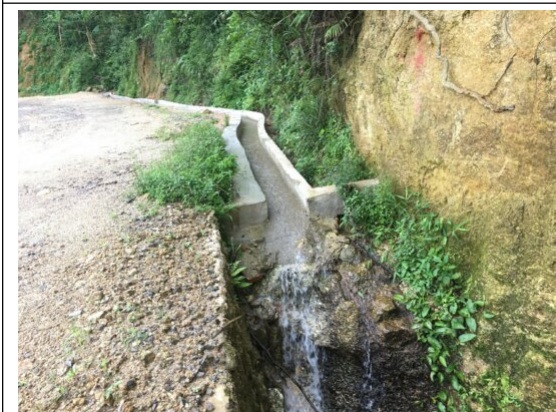
道路内侧混凝土排水沟
