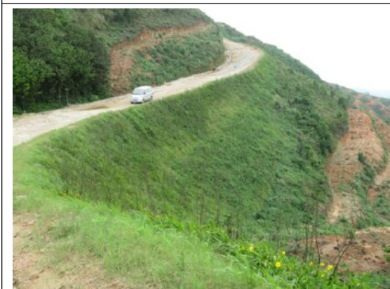
道路下边坡覆绿
