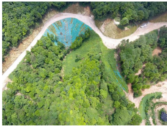
道路下边坡覆绿
