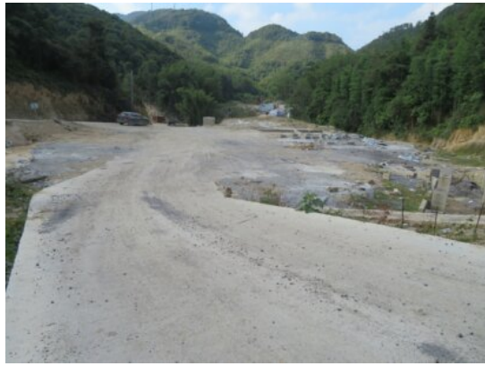
搅拌站覆绿前
