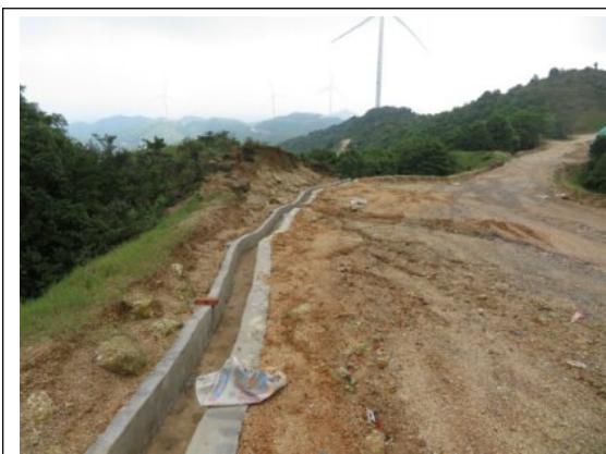
道路混凝土排水沟
