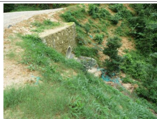
道路过水管涵处水口
