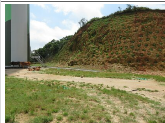
风机平台及上边坡覆绿
