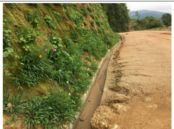
道路内侧混凝土排水沟
