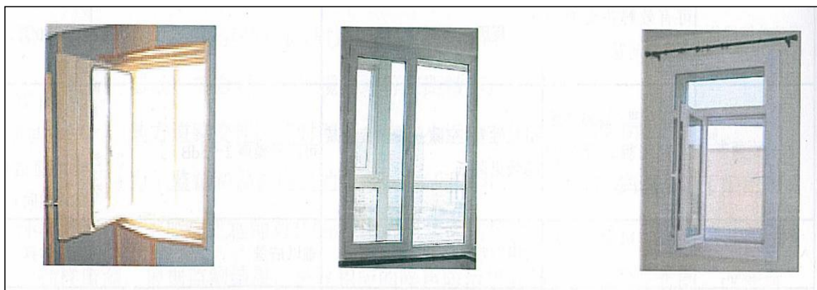
图 6.5-1 典型通风式隔声窗示意图
