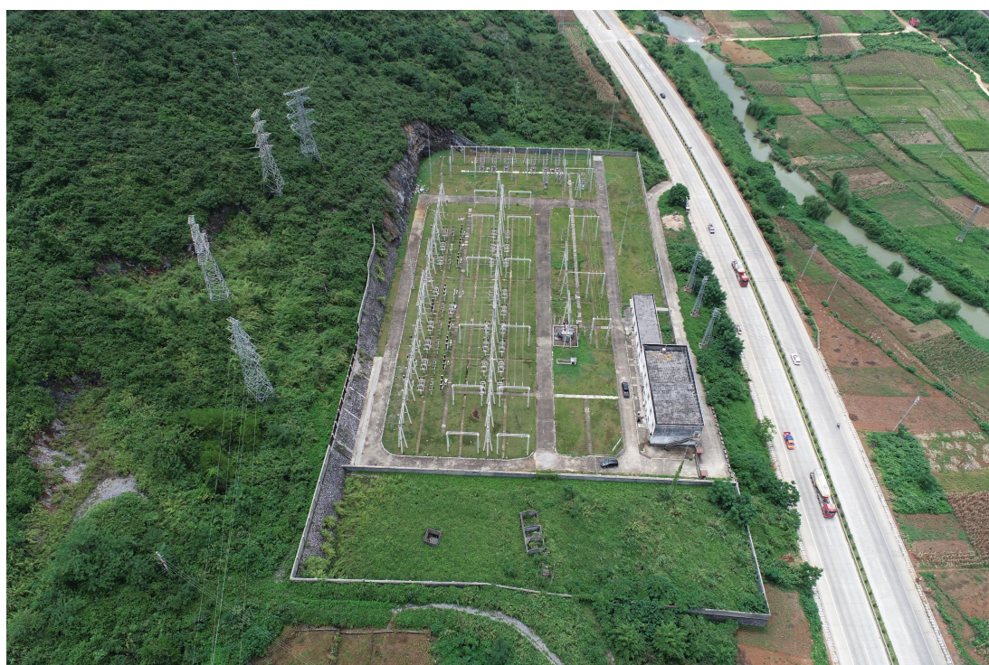
附图 2 110kV 白沙变电站
